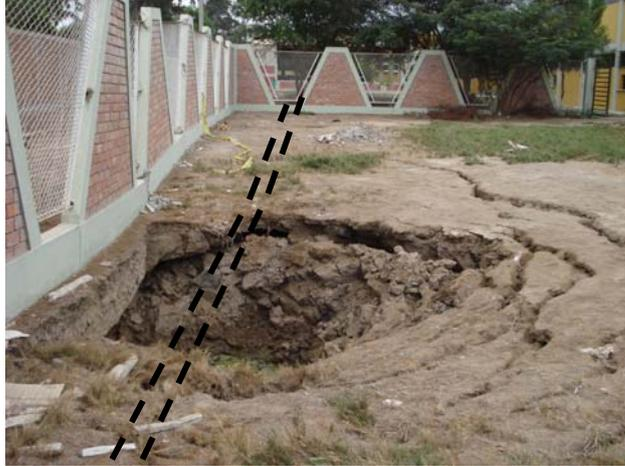
La tubería de desagüe que recorre paralela al muro, colapsó en varios tramos, haciendo fallar el suelo.
