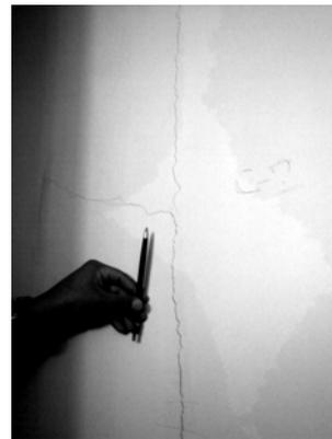
Sede de la Fiscalía en la ciudad de Lambayeque, en donde se presentan fallas por asentamientos. La capacidad portante de diseño fue calculada erróneamente en 4 kg/cm<sup>2</sup>, siendo en realidad de 0.70 kg/cm<sup>2</sup>. El diseño original fue de cinco niveles con zapatas conectadas.
