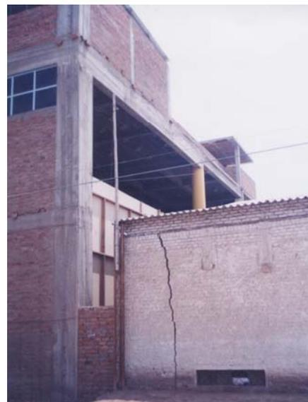
Excavación de sótano de iglesia del MMM, de 4 m de profundidad, en Chiclayo-Lambayeque, sin calzadura.
