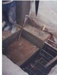
Colocación de armadura y luego concreto, en construcción de cimentación por tramos, por edificación débil de adobe vecina.
