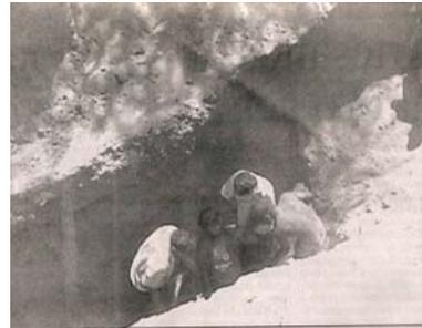
Dos obreros murieron por derrumbe de excavación de zanja de desagüe, en obra de Saneamiento, el 26 de Setiembre del 2006, en Cayalti, Departamento de Lambayeque. El suelo era arenoso y la excavación era de 3m de profundidad. Instantes en que son sacados.
